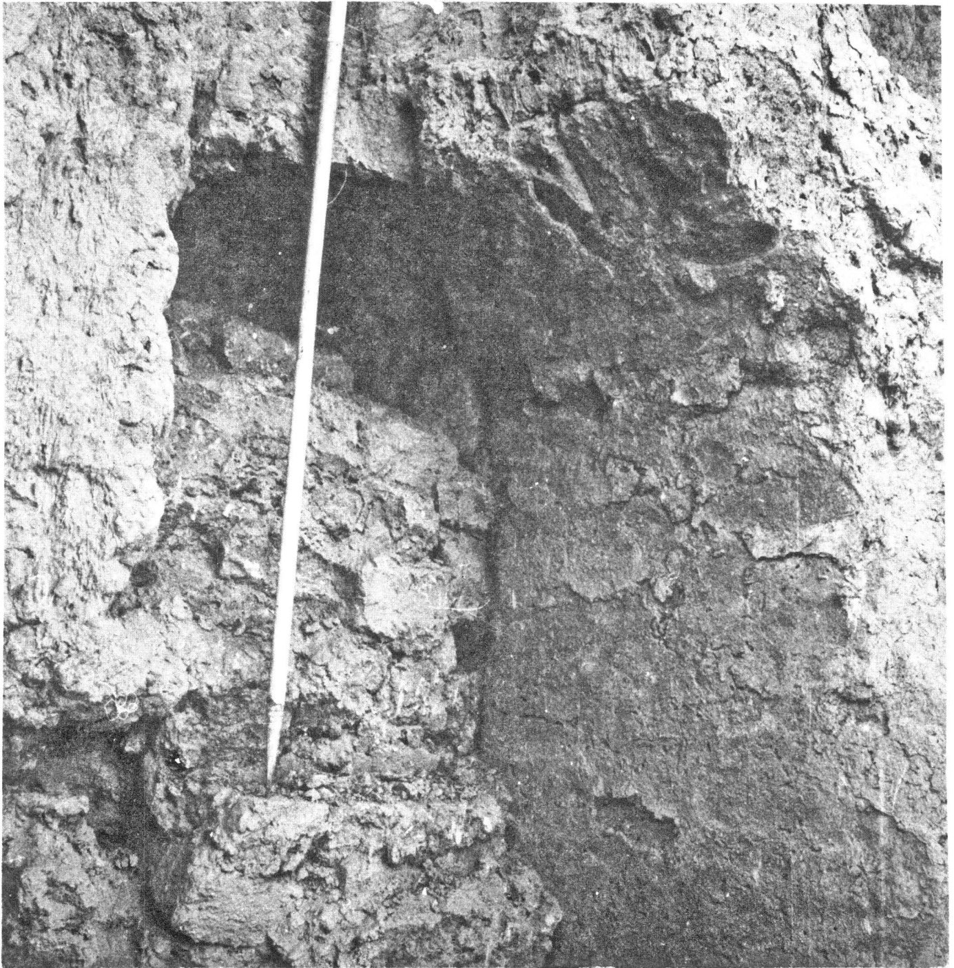
(تصویر شماره - ۱۹) باقیمانده هلی پوشش درگاه غربی تالار شمالی کمتوسط خاکبرداری غیرمجاز از طریق حفرچاه منهدم گردیده است
